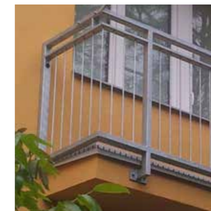
Obr.: Ocelové pozinkované zábradlí s tyčovou výplní
