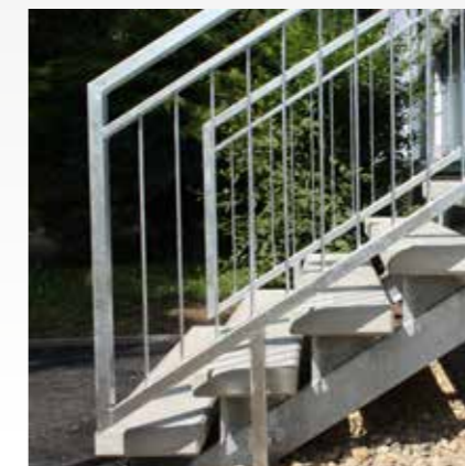
Obr.: Nové ocelové schodiště s prefabrikovanými stupnicemi
