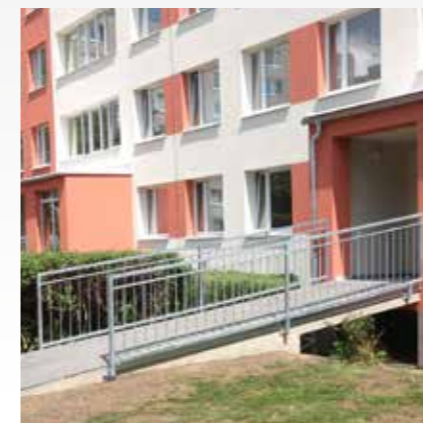
Obr.: Přístupová rampa
